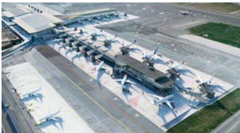
Oslo Gardemoen Expansion Non-Schengen Est OSLO, NORVÈGE
