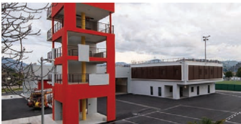
ELEVETOR TANK Centre anti-incendie et de secours SAINT-LAURENT-DU-VAR, FRANCIE
