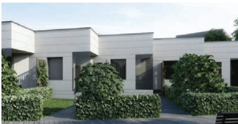
DRAINPANEL Centre privé de réadaptation BOLOGNE, ITALIE
